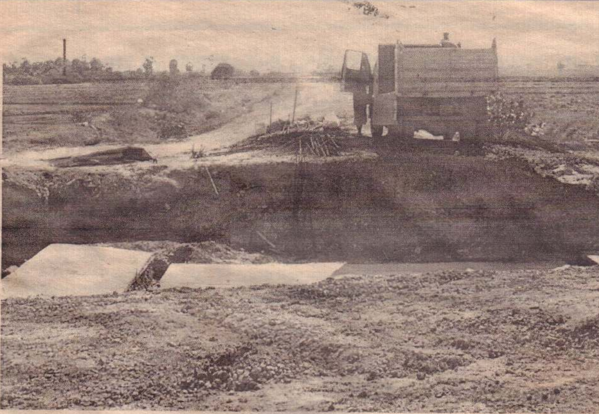
யாழ்ப்பாணத்துக்கான ரயில்பாதை அமைக்கும் பணிகள் துரிதமாக நடைபெற்று வருகின்றன. அரியாலை நாவலடிப் பகுதியில் ரயில் பாலம் புனரமைக்கப்படுவதுடன் பாதை அமையவுள்ள இடங்களில் கிரவல்மண் பரப்பும் பணிகளும் இடம்பெற்று வருகின்றன.
