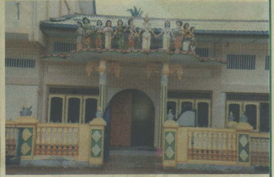
இரண்டு கோடி ரூபா செலவில் சமய, கலை வடிவங்களுடன் நிர்மாணிக்கப்பட்டுள்ள கோண்டாவில் கிழக்கு, ஆசிமடம் விநாயகர் மணிமண்டபத்தினை படத்தில் காணலாம். (படம்:- யாழ்ப்பாண மேலதிக நிருபர்)
