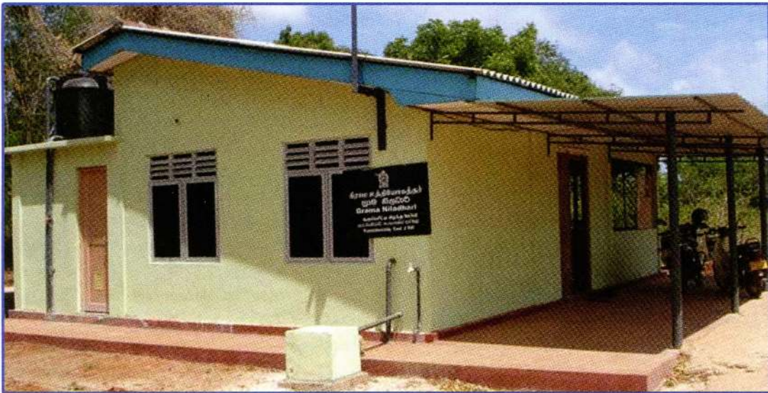
குரும்பசிட்டிக் கிராமம் 1990 இலிருந்து எதிர்கொண்ட அழிவுகளின் விளைவாக முற்றாக அழிக்கப்பட்டிருந்த நிலையில் 2011இல் மீள்குடியேற்றத்திற்கு அனுமதிக்கப்பட்ட பின்னர் கிராம முன்னேற்றச் சங்கத்தின் அயராது முயற்சியினால் மீள அமைக்கப்பட்ட கிராமசேவகர் அலுவலகம் (2012)
