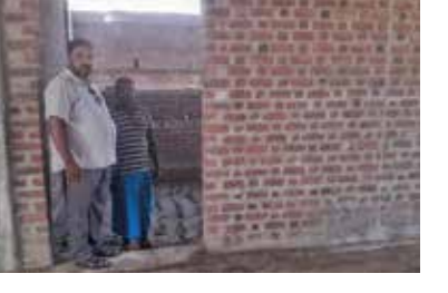
கட்டிட நிர்மாணப் பணிகளைப் பார்வையிட்டார். (05)
