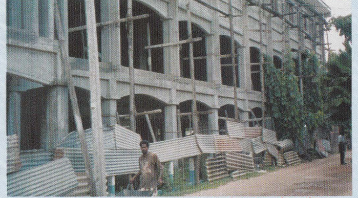
கட்டப்பட்டுக் கொண்டிருக்கும் Auditorium/Pavilion
