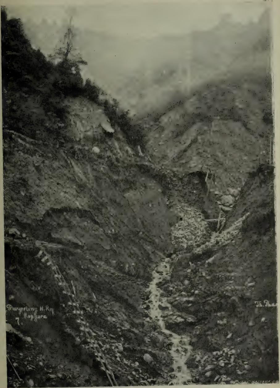
LA LIGNE DU CHEMIN DE FER APRÈS LES ÉBOULEMENTS
