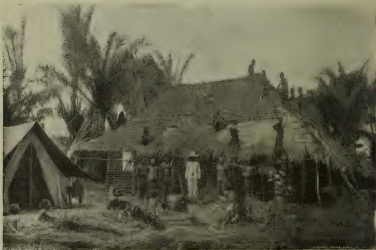
CHIMBEK EN CONSTRUCTION
