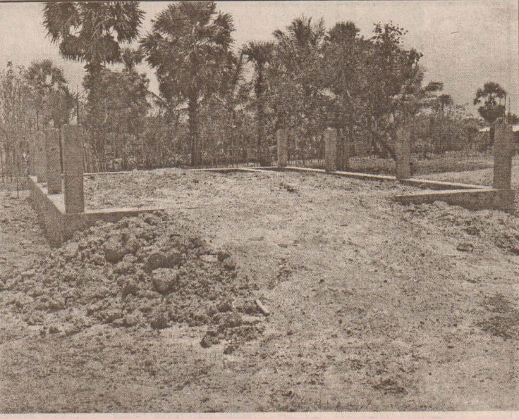
கண்டாவளைப் பிரதேச நாகேந்திரபுரம் வித்தியாலயத்தில் புதிதாக அமைக்கப்பட்டுவரும் நூல் நிலையத்தின் கட்டடப்பகுதிக்கு கிணற்று மண் இடப்பட்டுள்ளதைப் படத்தில் காண்க. இதனை நேரில் பார்வையிட்ட கிளிநொச்சி மாவட்ட அரசாங்க அதிபர் தி.இராசநாயகம் உடனடியாக அம்மண்ணை அகற்றி உரிய மண்ணினைப் பயன்படுத்தி கட்டடத்தைக் கட்டி முடிக்குமாறு ஒப்பந்தக்காரரிடம் பணிப்புரை விடுத்துள்ளார். (படம் :- சோதி, வரன்)
