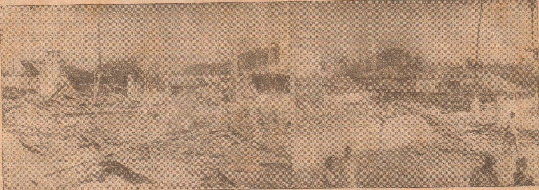
நேற்று அதிகாலை ஐந்து மணியளவில் நிகழ்ந்த குண்டுவெடிப்புச் சம்பவத்தில், குருநகர் முகாமின் முன்பகுதி தரைமட்டமாக இருப்பதை இங்கு காணலாம். இந்த முகாமை முன்னர் இராணுவத்தினர் பயன்படுத்தியிருந்தனர். கடந்த வருடம் ஜூலை கலவரத்தினால் பாதிக்கப்பட்டு அகதிகளாக வந்தவர்கள் சிலர் இந்த முகாமின் பின்பகுதியில் இருக்கின்றனர். இக்குண்டுவெடிப்புச் சம்பவத்தில் எவரும் காயமடையவில்லை. படம்: தேவா
