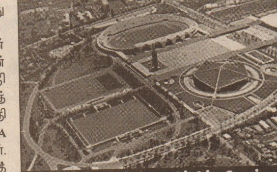
1964ஆம் ஆண்டு ஒலிம்பிக் போட்டி நடைபெற்ற KOMAZAWA விளையாட்டு மைதானம்.
