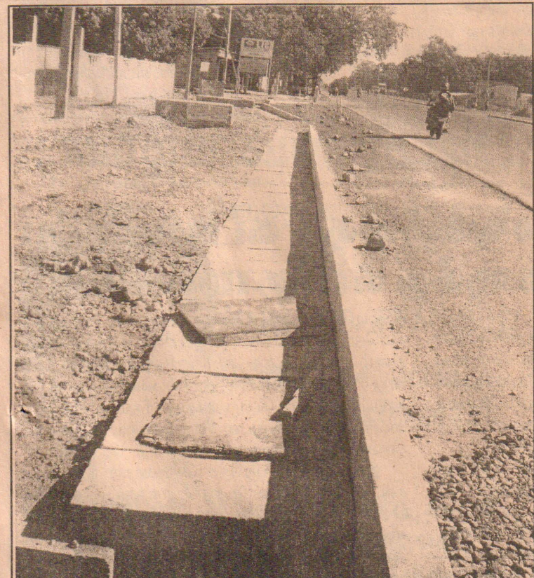
கிளிநொச்சி நகரப் பகுதியில் வீதி அகலிப்பு பணிகள் பூர்த்தியடைந்துள்ள நிலையில் வடிகால்கள் அமைக்கப்பட்டு வருகின்றன. (படம்: ஜெ.கலையகன்)
