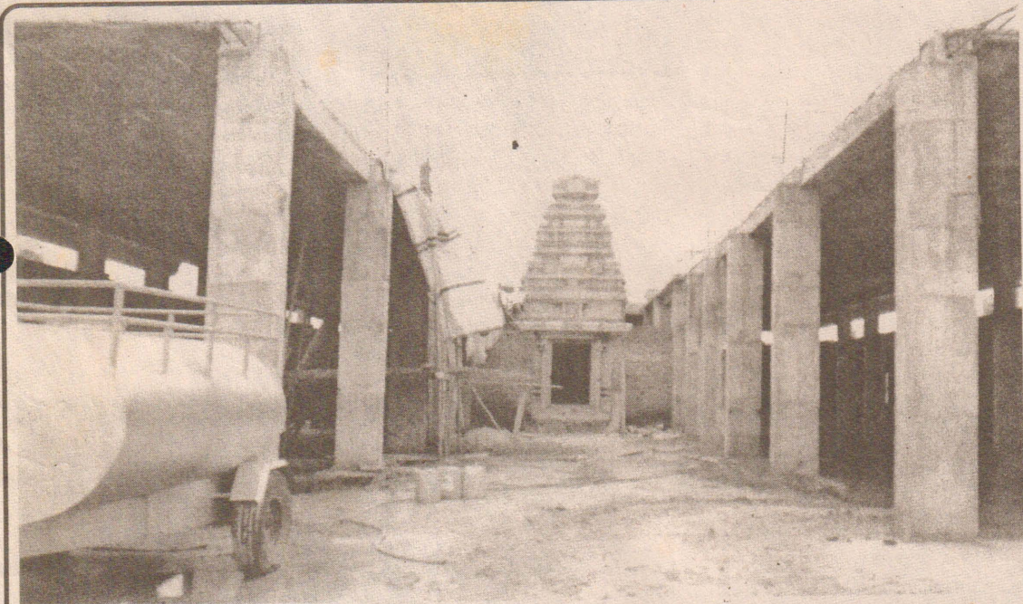
காரைநகர் துறைமுகம் சித்திரகூட சித்தி விநாயகர் ஆலயம் முழுமையான கருங்கற்களினால் அமைக்கப்பட்டு வருவதையும் அவ் ஆலயத்தில் 60 அடி உயரமான இரு கோபுரங்கள் அமைக்கப்படவுள்ள நிலையில் அவ்வேலைகளை துரிதப்படுத்தும் நோக்கில் கருங்கற்களை வெட்டும் இயந்திரம் பொருத்தப்பட்டு பாரிய கற்கள் வெட்டப்பட்டு வருகின்றமையை காணலாம்.(50)
