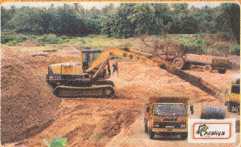
அரலிய மண் விநியோகம் - மணம்பிட்டிய
