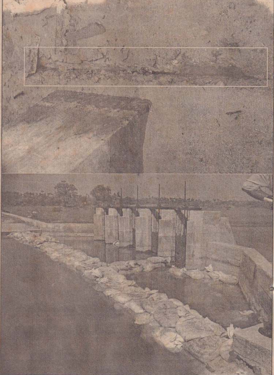
சரவணைப் பகுதியில் புத்தாக்கப்பட்ட உவர்நீர் தடுப்பு அணை சேதமடைந்திருப்பதையும் - நன்னீர், கடல் நீருடன் சேராதவாறு தடுப்பு அணை முன்பாகக் களிமண்ணைக்கொண்டு தற்காலிகமாக அமைக்கப்பட்ட தடுப்பணைகளையும் படங்களில் காணலாம். (படங்கள்: திபன்)
