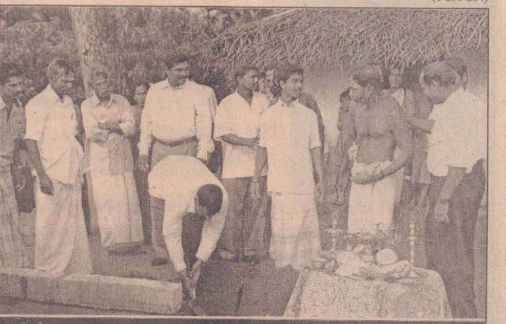
இச.ந.ஏ.ஏ நிறுவன நிதியுதவியுடன் பூநகரி - முழங்காவில் அபிவிருத்தி நிறுவனம், தமிழர் புனர்வாழ்வுக் - கழகம் என்பவை இணைந்து இடம்பெயர்ந்து முழங்காவில் பண்டிதர் குடியிருப்பிலுள்ள 109 குடும்பங்களுக்கு வீடுகளை அமைத்துக் கொடுக்கவுள்ளன. இதற்கான அடிக்கல் நாட்டும் நிகழ்வில் பூநகரி பிரதேச செயலர் அடிக்கல் நாட்டுவதைப் பட்டத்தில் காணலாம். (படம் - வேரவில் செய்தியாளர்)
