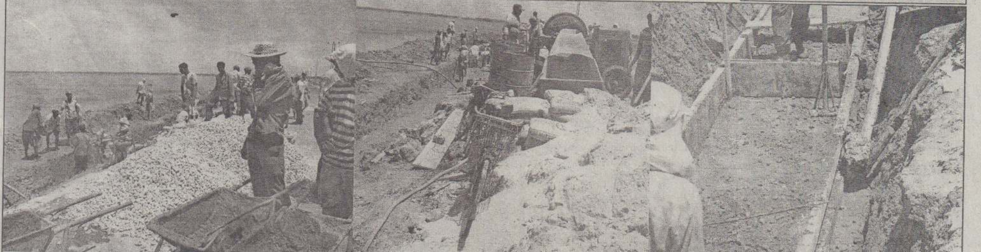
காரைநகர் - வட்டுக்கோட்டை - மூளாய் பகுதியை இணைக்கும் பொன்னாலைப்பாலம் அகலமாக்கும் பணிகள் தற்போதும் நடைபெற்று வருகின்றன. 22 அடி அகலமுள்ள இந்தப்பாலம் 33 அடியாக விரிவாக்கப்பட்டுள்ளது. பாலத்தை அகலமாக்கும் பணியில் வீதி அபிவிருத்தி அலுவலர் ஈடுபட்டுள்ளனர். (படங்கள்: லக்ஷ்மன்)
