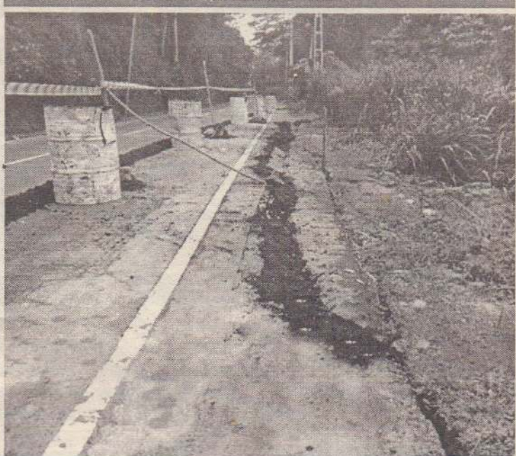
பாதிப்பு: கம்பளை- பேராதனை பிரதான வீதியில் பேராதனைப் பல்கலைக்கழக பொறியியல் பீடத்திற்கு அண்மையில் மண்சரிவு ஏற்படும் அபாயம் தோன்றியுள்ளது. இதற்கான அறிகுறியாக பாதை ஓரத்தில் லொடிப்பு தோன்றி கீழ் இறங்கியுள்ளது. (204)
