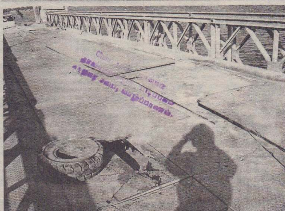
மட்டக்களப்பு, வலையிறவு சின்னப்பாலம் இடிந்து விழும் அபாய நிலையில் காணப்படுகின்றது. இந்தப் பாலத்தில் துவாரங்கள் ஏற்பட்டு அதை மறைப்பதற்காக இரும்புத் தகரங்கள் போடப்பட்டுள்ளன. (ச)
