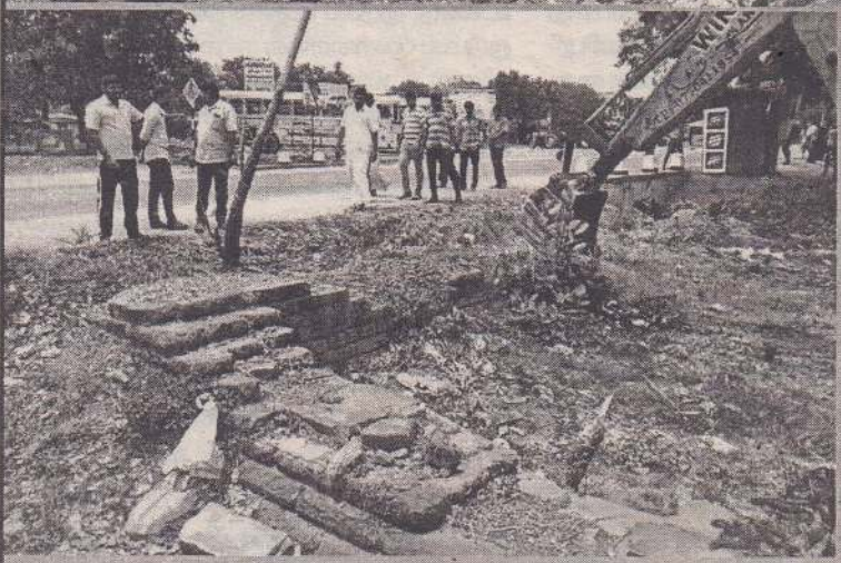
2009 ஆம் ஆண்டு இறுதியுத்தம் நிகழ்ந்ததன் பிற்பாடு கிளிநொச்சியினுடைய கலாசார பண்பாட்டு மண்டபம் மற்றும் சந்திரன் பூங்கா ஆகிய பகுதிகளில் பொலநறுவை
