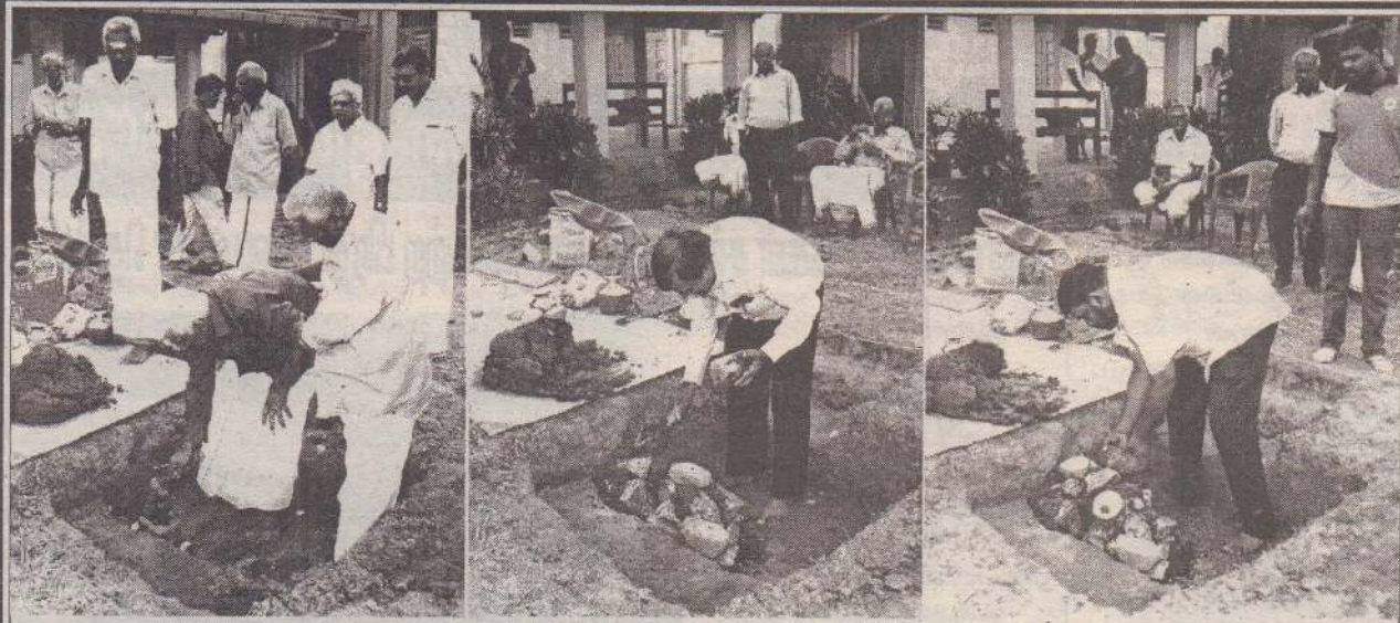
கரவெட்டி அம்பன் வைத்தியசாலையில் இரண்டு மாடிக் கட்டடம் அமைப்பதற்கான அடிக்கல் நாட்டும் நிகழ்வு விழா அண்மையில் இடம்பெற்றது. அம்பன் வைத்தியசாலையில் நோயாளர் விடுதி அமைத்து தருமாறு கரவெட்டி ஒன்றியத்தினால் விடுக்கப்பட்ட கோரிக்கைக்கு அமைவாக அரசினால் 27 மில்லியன் ரூபாய் நிதி ஒதுக்கீடு செய்யப்பட்டது. இந்த அடிக்கல் நாட்டும் நிகழ்வில் வடமாகாண சுகாதார சேவைகள் பணிப்பாளர் ஆ. கேதீஸ்வரன், கரவெட்டி சுகாதார வைத்திய அதிகாரி எஸ். சுதோஸ்குமார், கரவெட்டி ஒன்றியத்தின் தலைவர் உபாலி பொன்னம்பலம் மற்றும் ஒன்றியத்தின் பிரதிநிதிகள் எனப் பலர் கலந்து கொண்டு அடிக்கல் நாட்டினர். (படங்கள்: மகாலிங்கம்)
