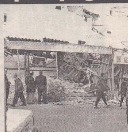
மக்கள் வீடுகளை விட்டு வெளியேறினர். மலைப் பகுதியில் இருந்து உருண்டு வந்த பாறைகள் வீதிகளில்
