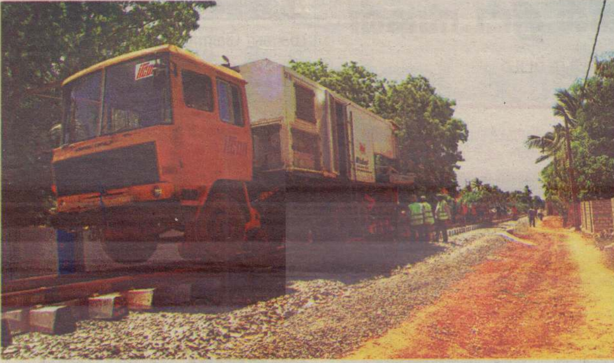
யாழ்ப்பாணம் ரயில் நிலையத்துக்கு அருகில் உள்ள ரயில் பாதையில் தண்டவாளங்களைப் பொருத்தும் இயந்திரம் இந்த வாகனத்தில் தான் கொண்டு வரப்பட்டுள்ளது. இந்த வாகனம் தங்களுக்குள்ளே இயந்திரத்தை வைத்தே தண்டவாளங்கள் பொருத்தப்படுகின்றன. (வ-21)
