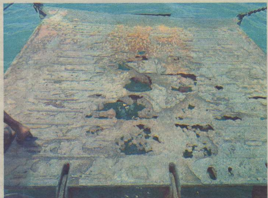
காரைநகருக்கும் உள்காவற்றுறைக்கும் இடையிலான கடற்போக்குவரத்துக்குப் பயன்பாட்டிலுள்ள கேபிள் கம்பியில் நகர்த்தப்படும் இரும்பினாலான பாதை உக்கிர ஓட்டை உடைசல்களுடன் காணப்படுகிறது. அதனுடாகப் பயணம் செய்பவர்கள் பல மாதங்களாக சிரமத்துக்கு மத்தியில் அச்சத்துடன் பயணிக்கும் நிலைக்குத் தள்ளப்பட்டுள்ளனர். (கு-4)
