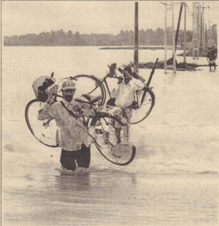
தற்போது பெய்துவரும் அடைமழை காரணமாக கல்முனை, நாவிதன்வெளி பிரதேசங்களை இணைக்கும் கிட்டங்கி பாலத்துடனான வீதி வெள்ளத்தில் மூழ்கியுள்ளது. இதனால் மக்கள் சிரமங்களுக்கு மத்தியில் வீதியைக் கடந்து செல்கின்றனர்.
