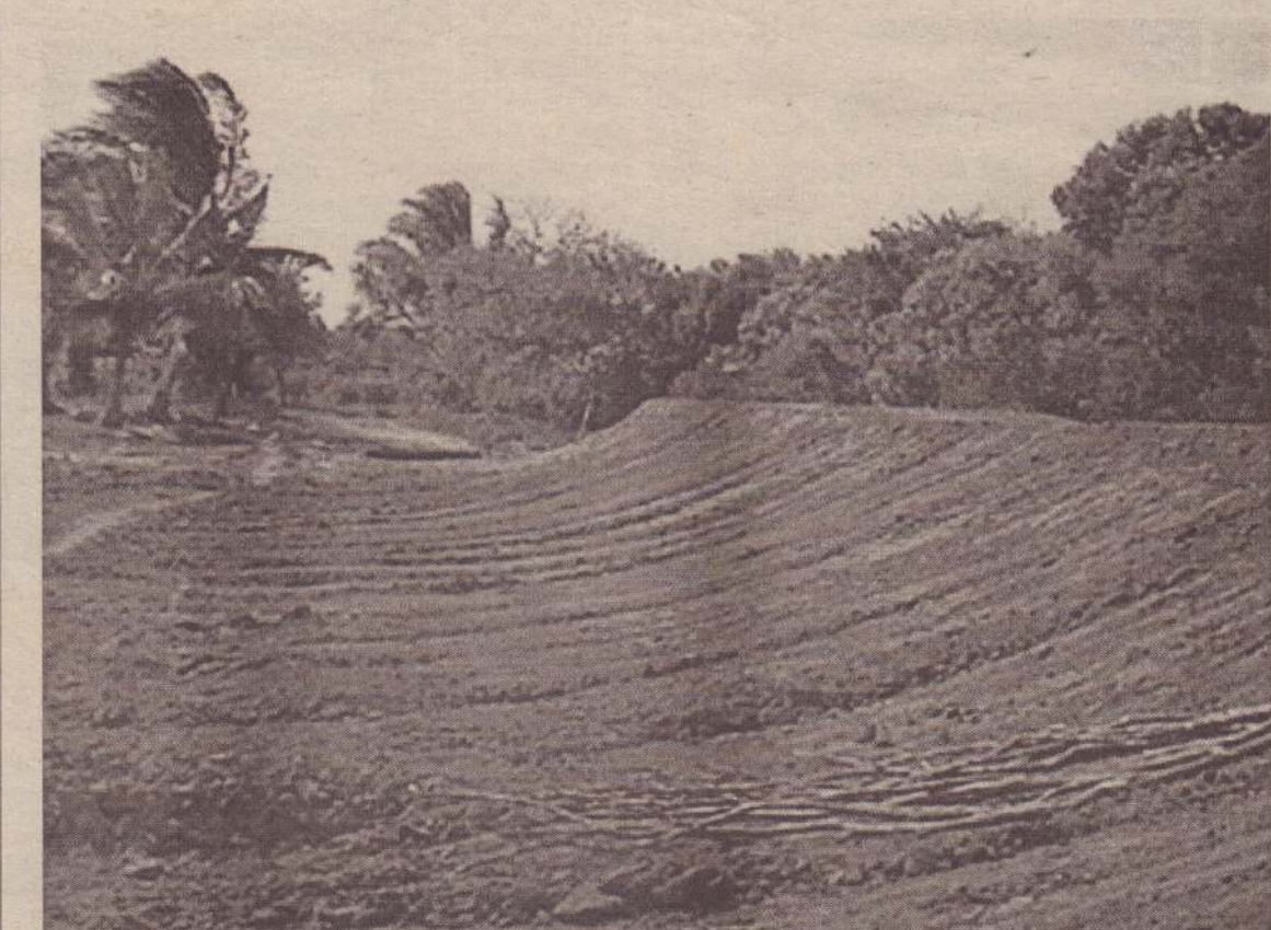
கிளாலி கடற்கரைப் பகுதியில் உள்ள வயல் நிலங்களில் கடல் நீர் உட்புகாதவாறு யு.எஸ்.எயிட் நிறுவனத்தின் நிதி உதவியுடன் பற்றிக்கல் அக்சன் நிறுவனத்தினால் மண் அணைகள் அமைக்கப்பட்டு வருவதைக் காணலாம். (வ-23)
