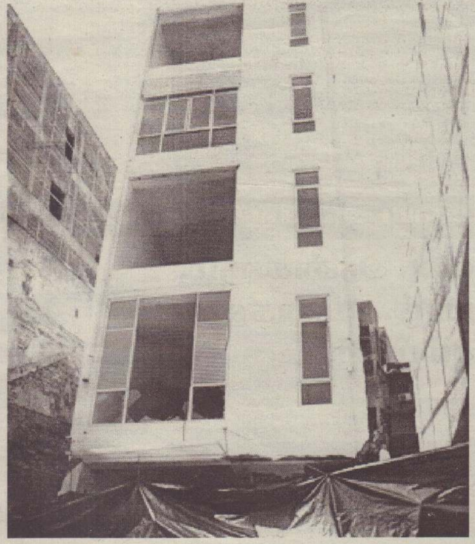
புறக்கோட்டை மெலிபன் வீதியிலுள்ள ஏழுமாடிக்கட்டிடம் ஒன்று பின்புறமாக சரிந்து குமார வீதியிலுள்ள கூட்டிட மொன்றுடன் சாய்ந்துள்ளது.
