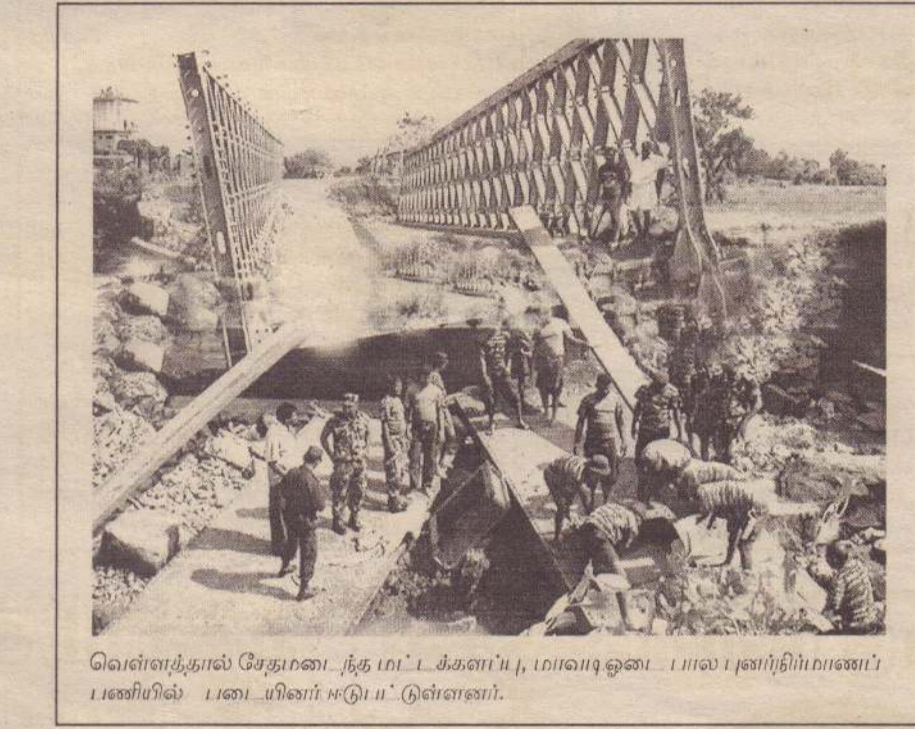
வெள்ளத்தால் சேதமடைந்த மட்டக்களப்பு, மாவட்ட ஓடை பாலம் புனர்திருப்பணியில் பணியினர் ஈடுபட்டுள்ளனர்.
