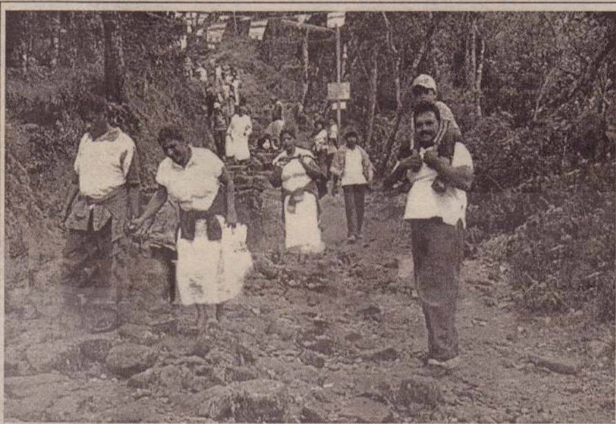
சிவனொளிபாதமலைக்குச் செல்லும் நடைபாதையில் படிக்கட்டுகள் சேதமடைந்து காணப்படுகின்றன. இதனால் பாத யாத்திரையை மேற்கொள்வதில் பத்தர்கள் சிரமத்துக்கு உள்ளாகின்றனர்.
