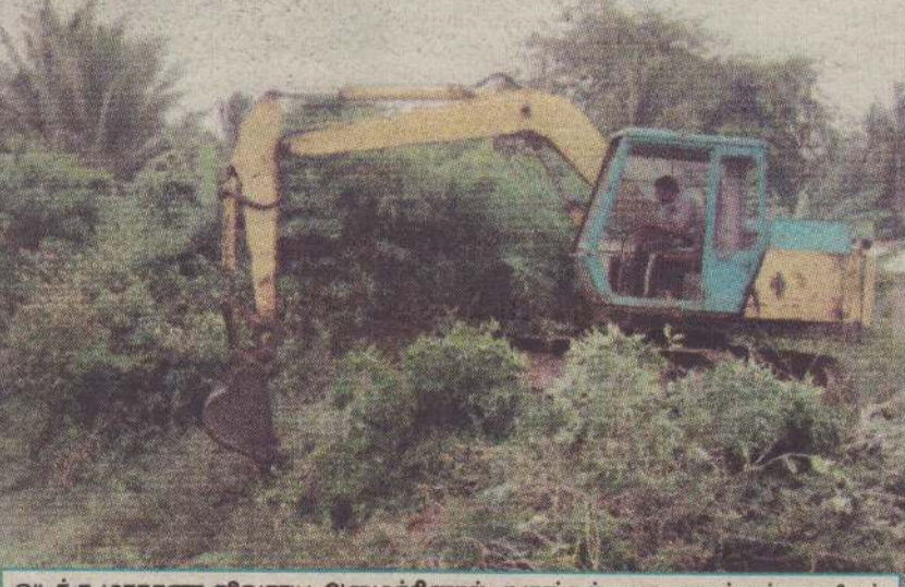
வடக்கு மாகாண விவசாய அமைச்சினால் குளங்கள் புனரமைக்கும் பணிகள் முன்னெடுக்கப்பட்டுள்ளன. இதனடிப்படையில் தற்போது திருநெல்வேலி பரவைக்குளத்தின் தடுப்பணைகள் போடப்பட்டு தூர்வாரப்படுகின்றது. பெரிய இயந்திரங்களின் உதவியுடன் புனரமைப்புப் பணிகள் இடம்பெறுகின்றன. (7)
