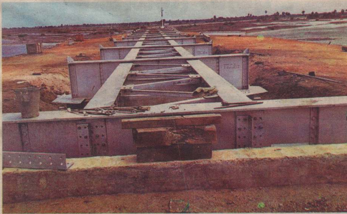
நாவற்குழியில் புகையிரதப் பாதைக்கான பாலம் அமைக்கப்படும் பணிகள் துரித கதியில் நடைபெற்று வருகின்றன. 210 மீற்றர் நீளம் கொண்ட இந்தப் பாலம், 45 அடி ஆழமான எட்டுத் தூண்களில் நவீன இயந்திரங்களின் உதவியுடன் அமைக்கப்பட்டு வருகின்றது.
