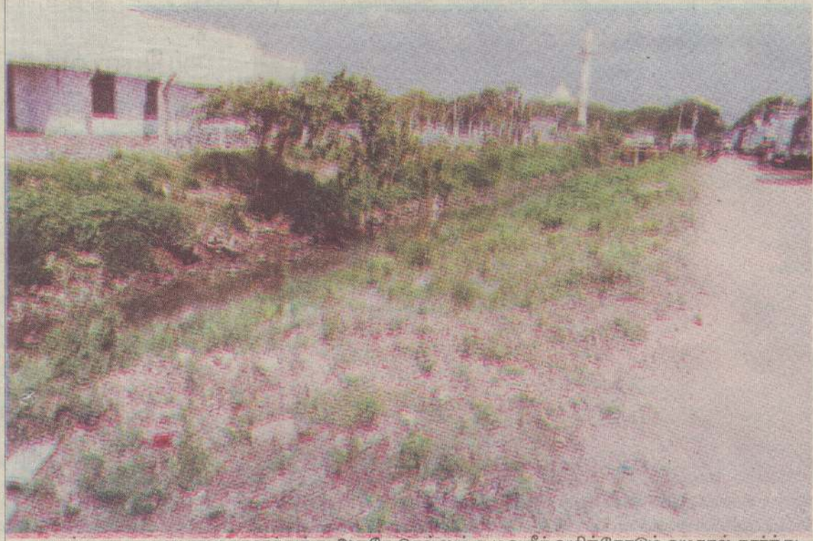
யாழ்.மாநகர சபை மைதானத்துக்கு அருகே செல்லும் கழிவு நீர் வழிந்தோடும் வடிகால் தூர்ந்து பழுதடைந்த நிலையில் உள்ளது. அத்துடன் வடிகால் அருகே செல்லும் வீதியும் பலத்த சேதமடைந்து காணப்படுகின்றது. நகரில் உள்ள வடிகால்கள் ஊடாக வரும் கழிவுநீர் பின்னர் இந்த வடிகால் ஊடாகவே கடலுக்குள் செல்கிறது. (கு-ஐ-17)
