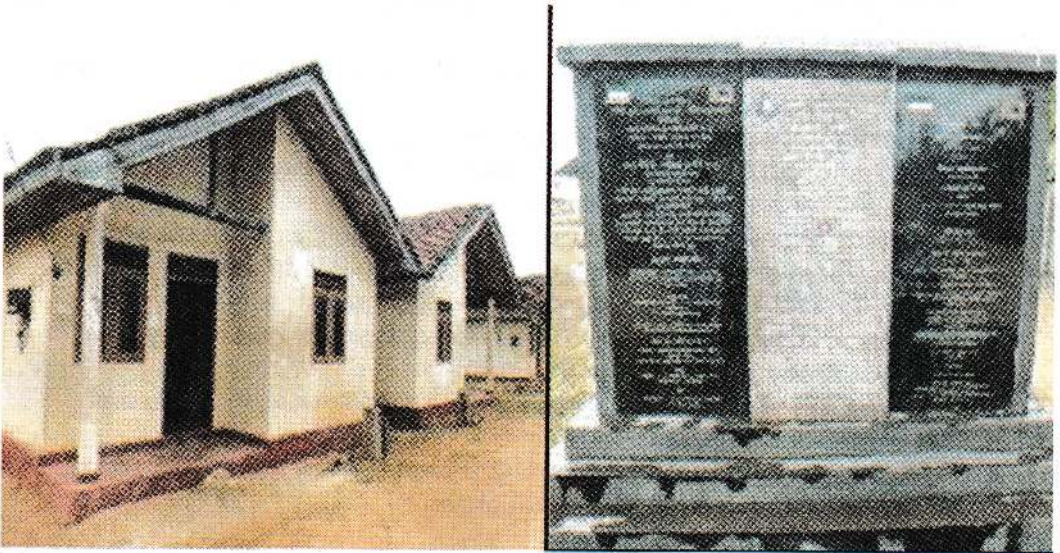
வெளவாலோடை 100 வீட்டுத்திட்டம் - ஜபர் அல்அஹமட் நகரம் - குவைத் கிராமம்
