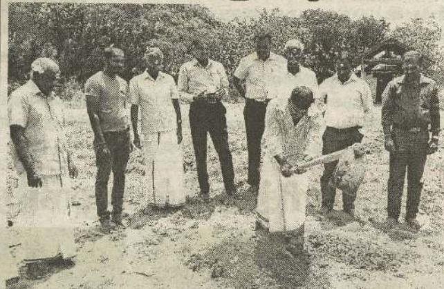
வதிரி கண்ணகை அம்மன் ஆலயத்திற்கு அருகில் அமைந்துள்ள குளத்தினை ஆழமாக்குவதற்கும் குளத்தினை சீரமைப்பதற்கும் வடக்கு மாகாண சபை உறுப்பினர் க. தர்மலிங்கம் தனக்கு ஒதுக்கப்பட்ட நிதியில் இருந்து பத்து இலட்சம் ரூபா வினை ஆலய நிர்வாக சபை உறுப்பினர்களிடம் கையளக்கும் நிகழ்வும் குளத்தினை ஆழமாக்குவதற்கான ஆரம்ப நிகழ்வும் அண்மையில் நடைபெற்றன. (இ-60)
